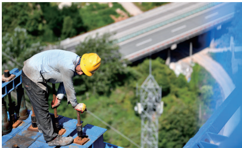
工人在西延高铁王家河特大桥施工
