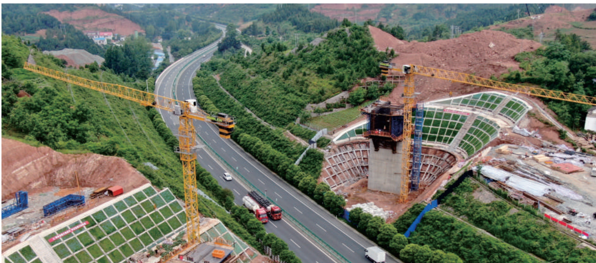
西十高铁陕西段山阳跨福银高速特大桥施工现场
